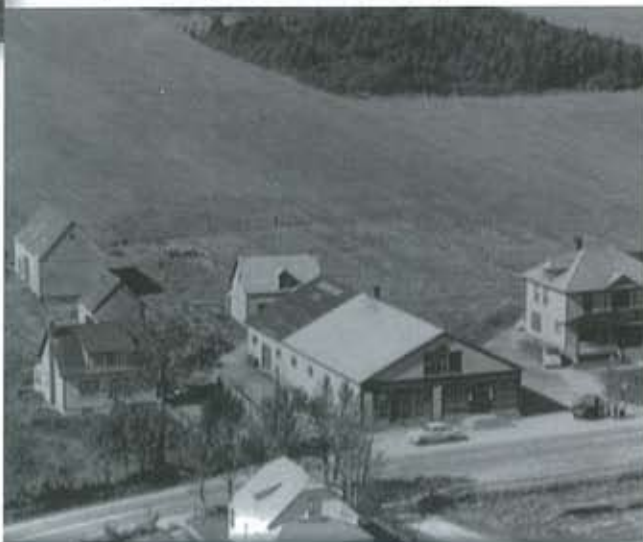
▲ Le magasin vu du ciel en 1954. Source: Rémi Cloutier.
